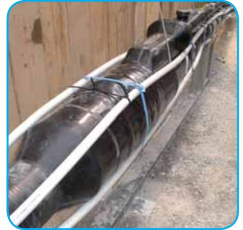
Cavi schermanti in prossimità del giunto del cavo AT.
